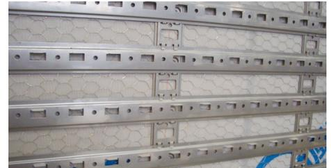
墨出し後、構造体にキック網をステップル等で仮止めした後、専用ビス・アンカーを選択し、自重受け金具を確実に取り付けます。ベース金具を自重受け金具のセンター部で3mm以上の間隔を空けながら取付します。1mあたり10本以上のビス・アンカーを使用してください。
