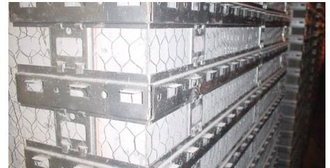
コーナー部はベース金具の凸部分を切断し折り曲げます。階層エキスパンション部や開口廻りには、補強バンド、補強バンドを使用してください。
