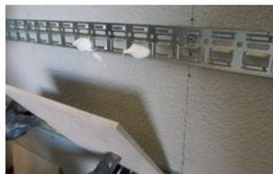
タイル1枚につき4~8点程度接着剤が基盤に確実に絡むように塗布し、タイルをもみ込むように貼り付けます。
