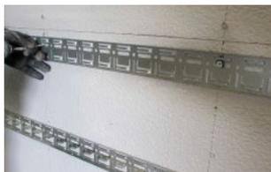
墨出し後、構造体に合わせ専用ビス・アンカーを選択し、躯体に基盤を確実に取り付けます。1基盤あたり6~8本のビス・アンカーを使用してください。
