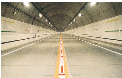
中部縦貫自動車道「小鳥トンネル」
