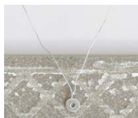
●リベット工法 ステン線
