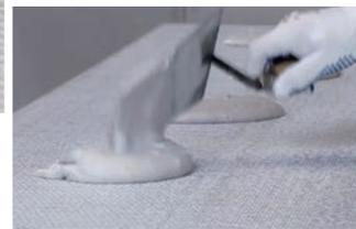
タイル裏面に接着剤 (ここではウルトラライト S2を使用) を塗布。まず接着剤を滑らかなコテで薄く塗り広げ、最低4mmのクシ目コテを使用し、端までしっかり接着剤を塗布します。
