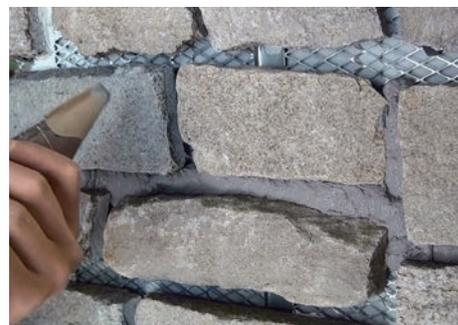
目地パック等を使用して、モルタル目地材を詰めていきます。目地材の硬化を確認した後、竹べら等で余分な目地材をかき落としながら仕上げていきます。タイル・石材の表面に付着した目地材はブラシ等で除去してください。
